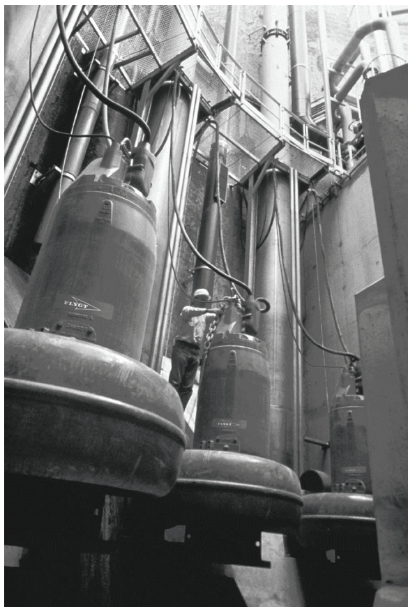
Рис. 66. Погружные насосные агрегаты с высокой производительностью 20
